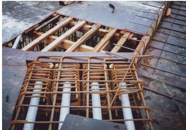
Gambar 6.10 Tulangan Confinement pada End Zone
