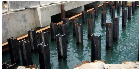
Gambar 12.18 Tiang Profil Baja H [7]
