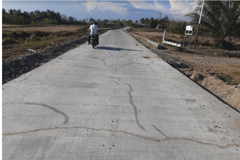
Gambar 5.2 Keretakan pada jalan beton sebelum difungsikan [8]
