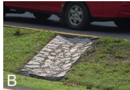
B: Penyaluran air hujan dari jalan raya ke drainase
