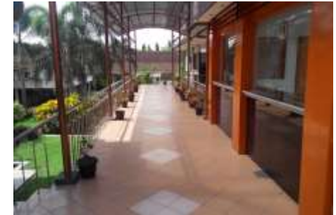
Selasar penghubung yang menyambungkan underpas dengan ruang tunggu pada Stasiun KA Maguwo
