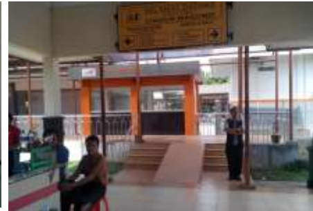
Ujung underpas penghubung pada Stasiun KA Maguwo
